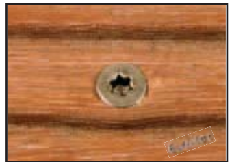
Vorbohren + Terrasotec-Schraube
